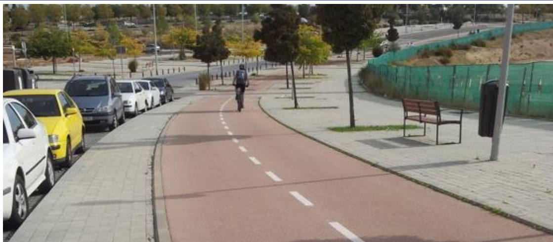
Foto 6. Cambio de cota entre la “acera-bici” y el espacio peatonal en Valdebebas.
