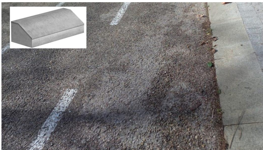
Detalle bordillo montable carril bici
